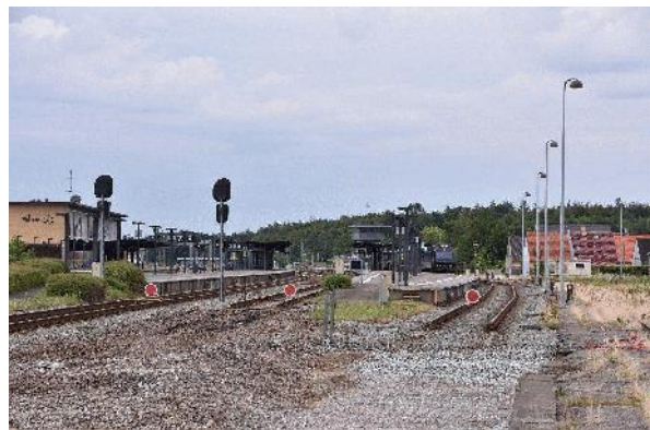
Spor 3, 4 og 5 har ikke forbindelse sydpå, og spor 5 har mistet det sydlige PU, så togvejen er nu noget kortere.
